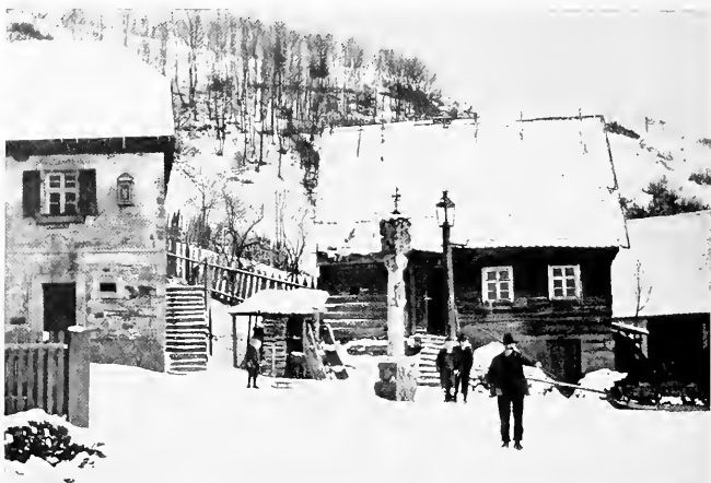
22. Stallhaus, Blockbau, Wallenfels im Frankenwald, Oberfranken
